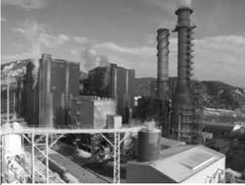
Bolu Göynük Termik Enerji Santrali
