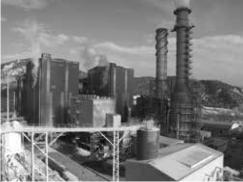
Bolu Göynük Termik Enerji Santrali
