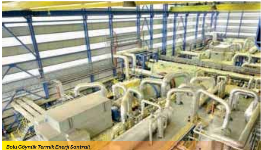
Bolu Göynük Termik Enerji Santrali
