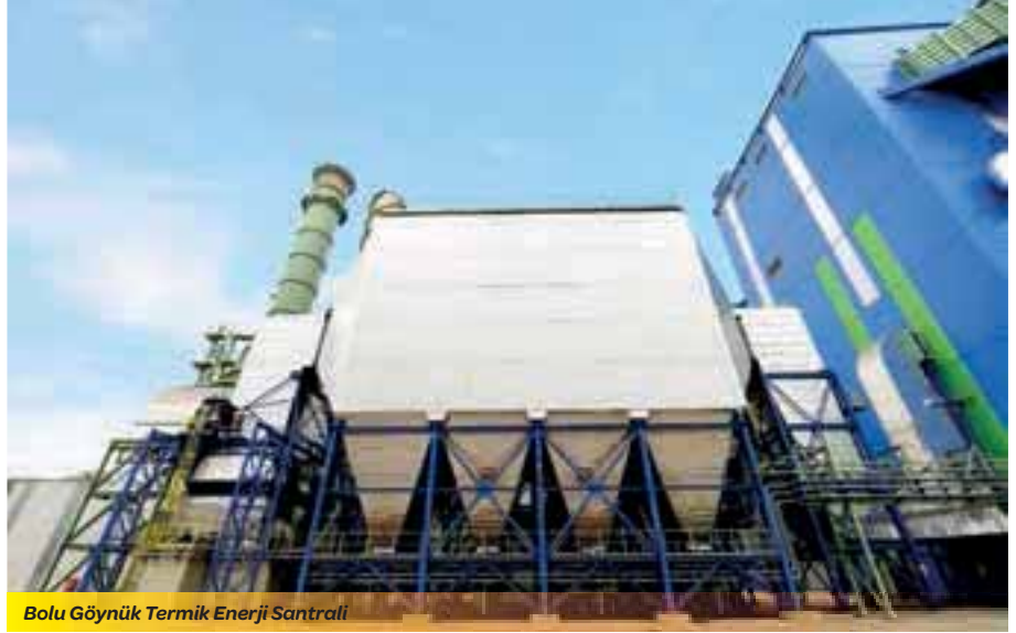
Bolu Göynük Termik Enerji Santrali
